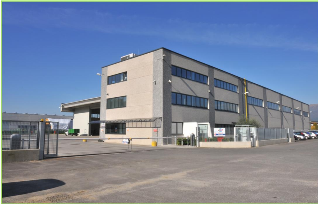
Figura 1 - Immagine dell'impianto di Lurago d'Erba: ingresso carraio
